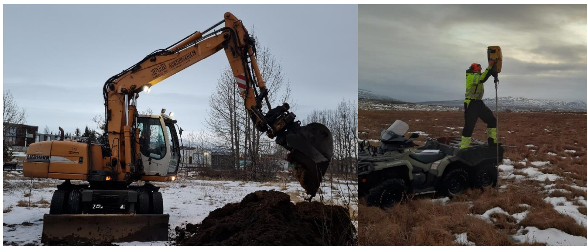
MYND 3.1 Hjólagrafan (t.v.) sem notuð var til verksins og cobra slagborinn (t.h.).
